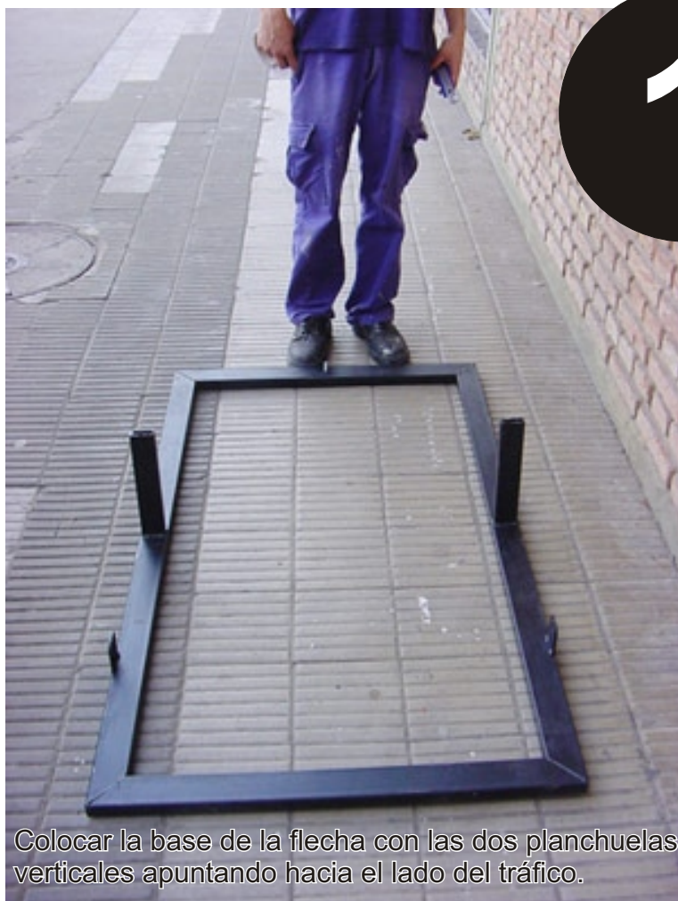
Insertar el soporte plegado en los dos caños estructurales que están soldados en el centro de la base.
